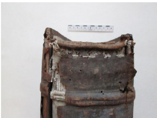
Foto 14: Objekt vor der Restaurierung; Kapitalbereich am Kopf
